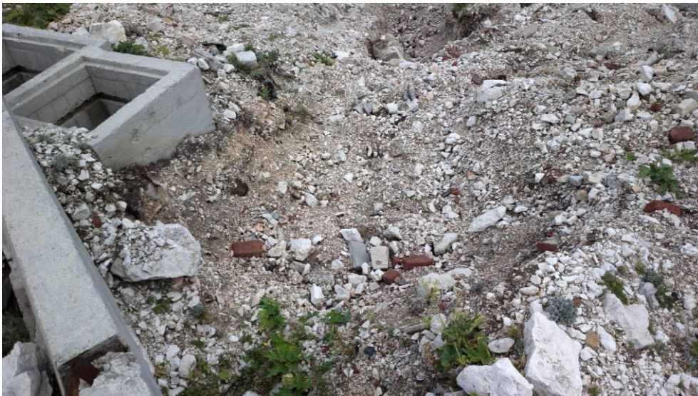
Slika 3. Prostor za ugradnju novog rezervoara
