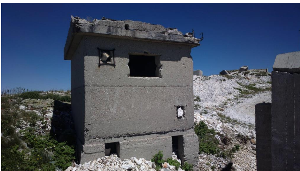
Slika 5. Otvori na postojećem objektu
