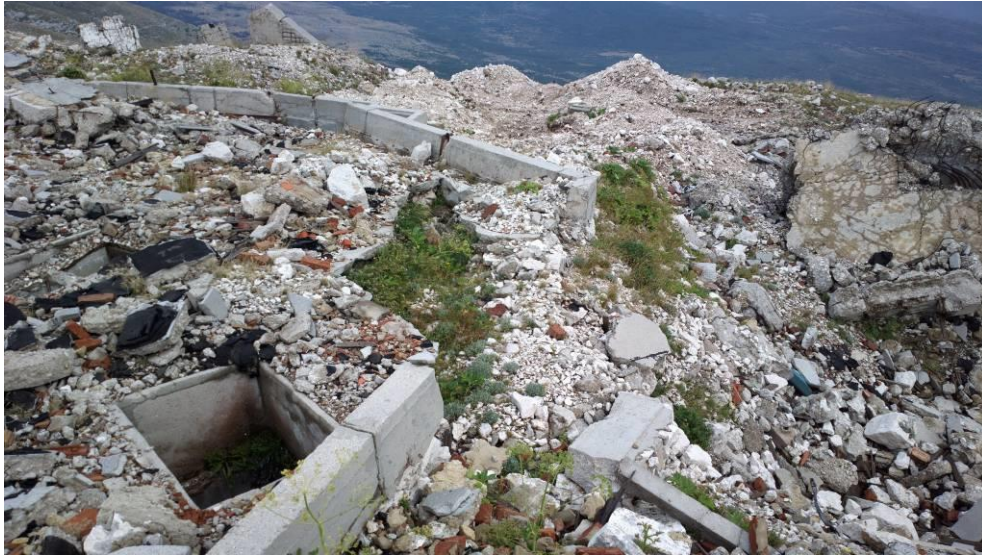
Slika 2. Oštećenje donjeg ruba slivne plohe
